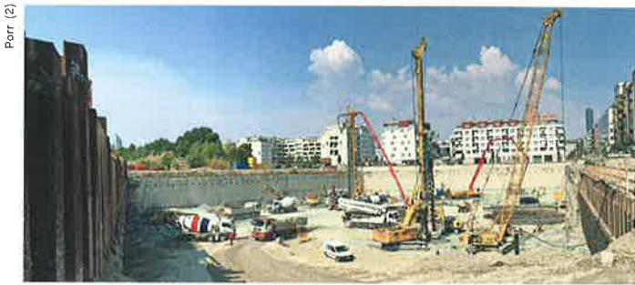
Bohrpfahlarbeiten Baufeld 8 im Schutz der Schlitz- und Spundwandumschließung.
